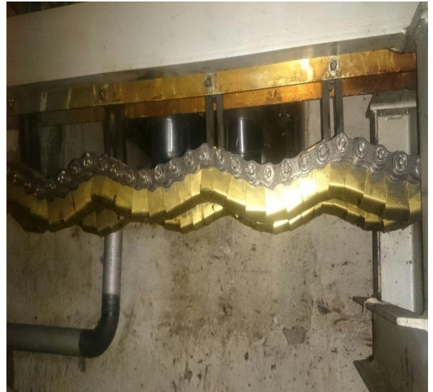
Después de limpiar
