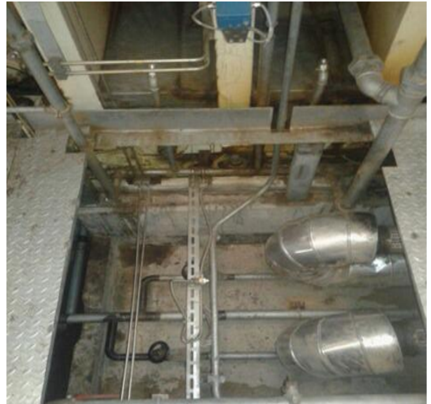
Después de limpiar
