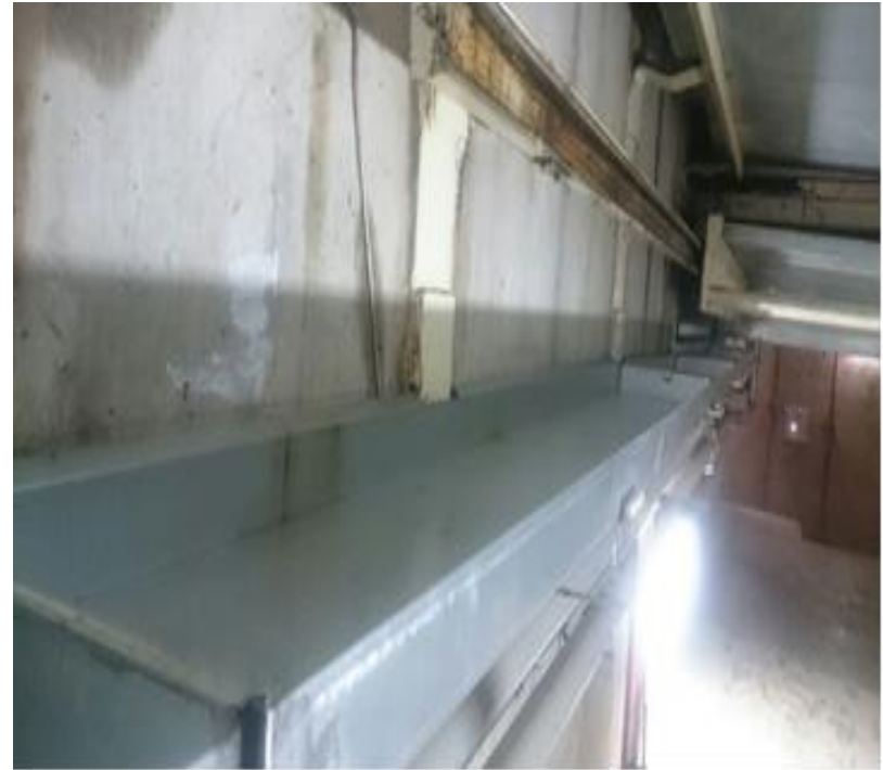
Después de limpiar
