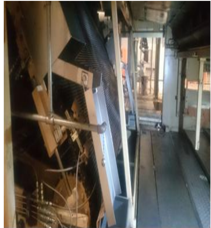
después de limpiar
