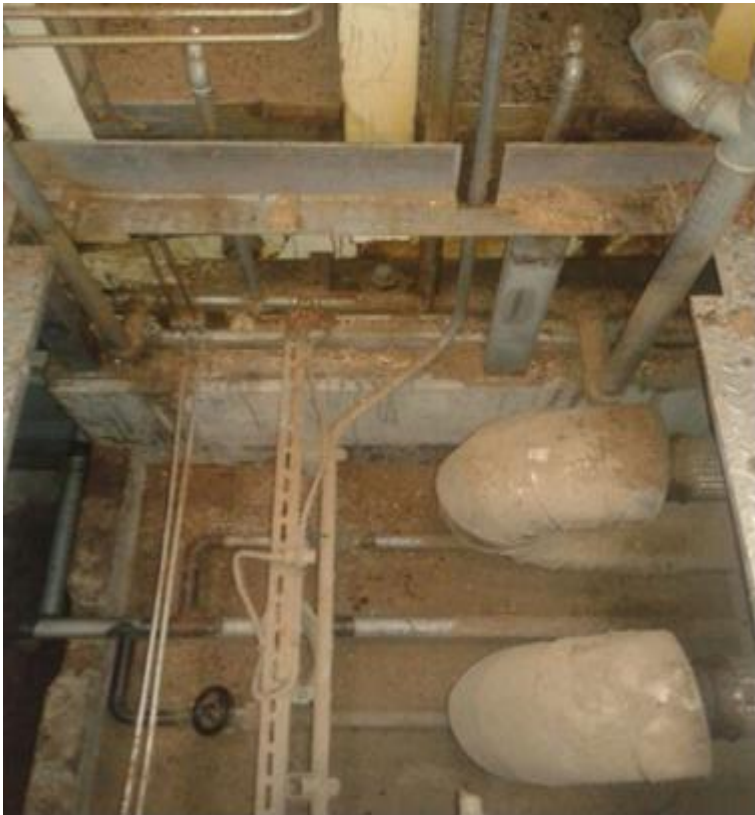
Bajo grating antes de limpiar
