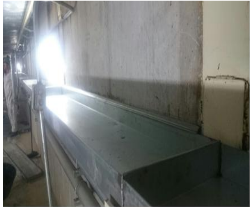
Después de limpiar
